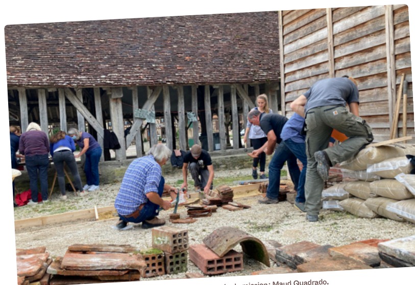
PNVFO Piney, 2021 La forte implication des habitants s'est concrétisée à travers un chantier participatif valorisant le réemploi.
